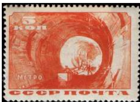
Прокладка тоннеля метро
