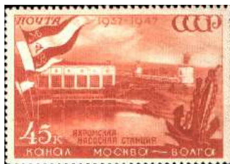
Яхромская насосная станция
