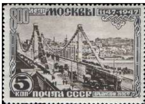
Крымский мост (арх. А. Власов, инж. Б. Константинов)
